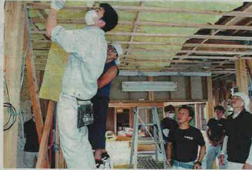
宮崎直也さん（右から3人目）の指導で高性能な断熱と気密の施工法を学ぶ参加者ら＝大野市春日で
