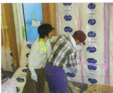
夫唱婦随で断熱材を丁寧に施工
