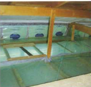
天井は防湿気密層のため既存天井を剥がした。リフォーム時天井の気密は特に重視する
