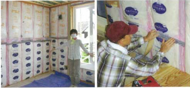
壁 高性能グラスウール(袋入り)100mmを充填 貫通部コンセント部なども丁寧に気密処理
