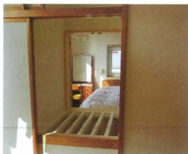
1階のリビングから吹き抜ける通気口 これによって2階に暖房器を設置しないで済む
