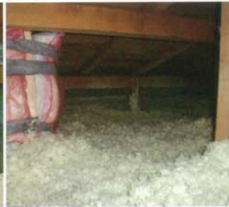
天井は防湿気密層のため既存天井を剥がした。リフォーム時天井の気密は特に重視する
