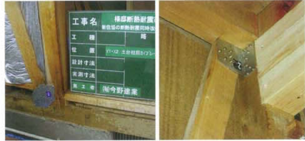
耐震性能 基礎の鉄筋を確認 改修計画通りの耐震金物を入念に施工する
