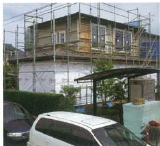
外部施工 断熱材→防風透湿シート→通気層→外壁と仕上げられてゆく
