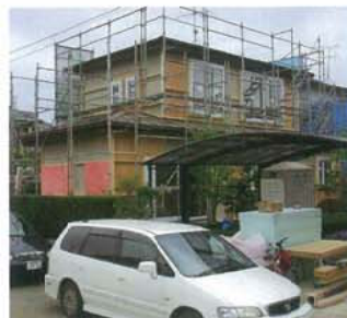
外部施工 断熱材→防風透湿シート→通気層→外壁と仕上げられてゆく
