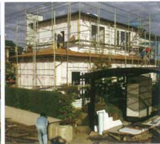
外部施工 断熱材→防風透湿シート→通気層→外壁と仕上げられてゆく
